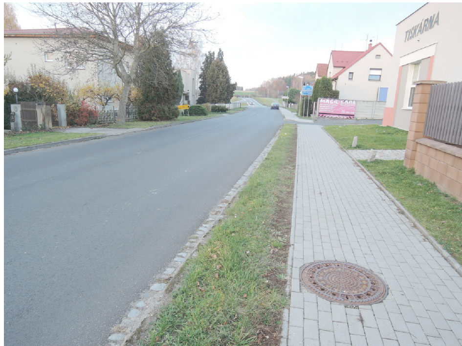
Zámecká ulice, pohled severním směrem ke křižovatce se silnicí I/21
